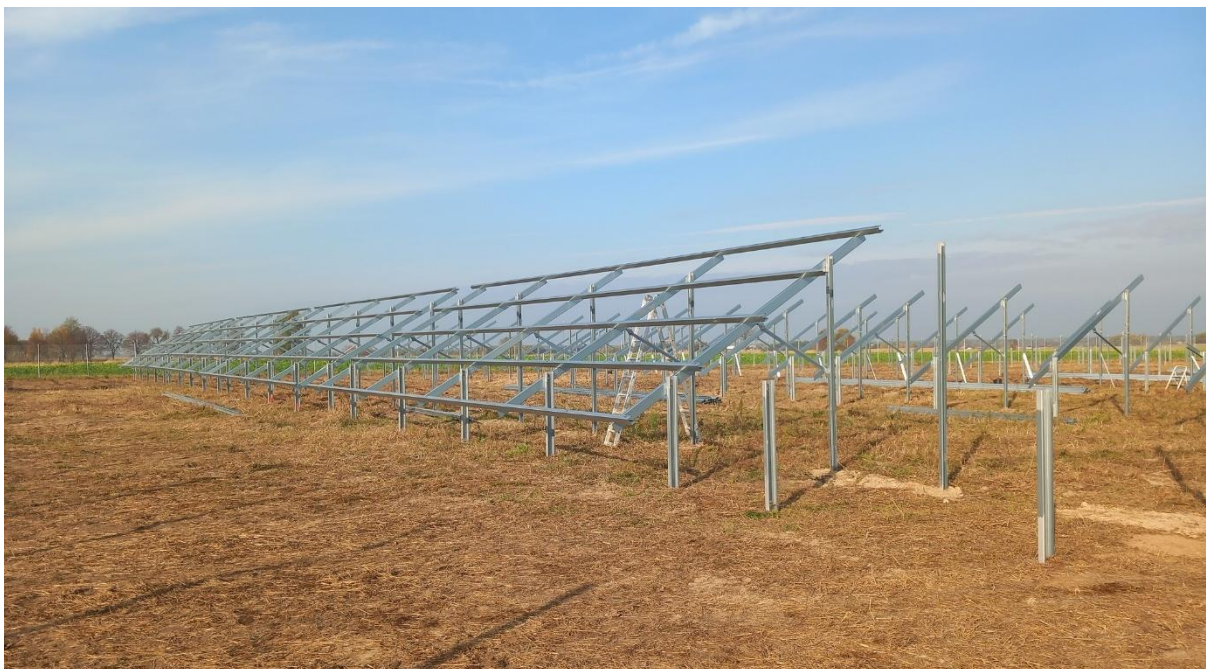
Fot. 8.1-2: Metalowe stelaże pod moduły fotowoltaiczne
