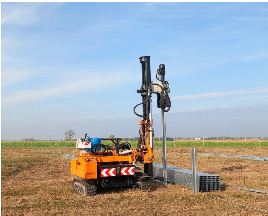
Fot. 8.1-1: Montaż pionowych profili wbijanych w ziemię za pomocą kafara
