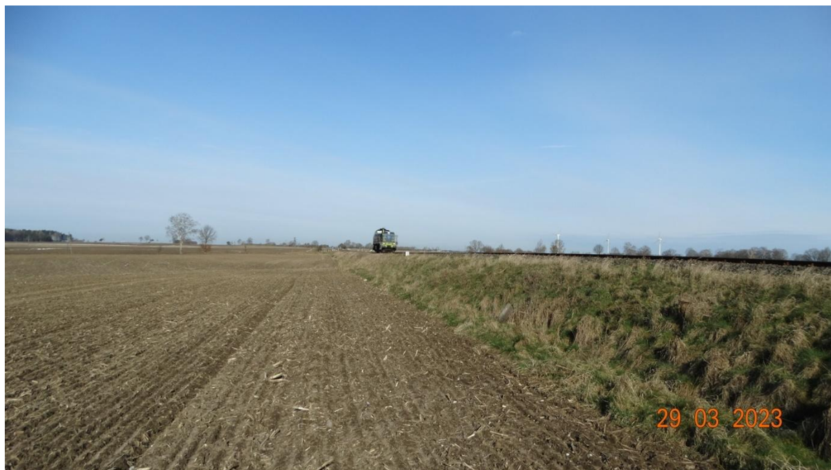
Fot. 8.2-2: Widok wzdłuż północnej granicy działki nr 307/2 w kierunku zachodnim, widoczne czynne tory kolejowe na niewielkim nasypie.
