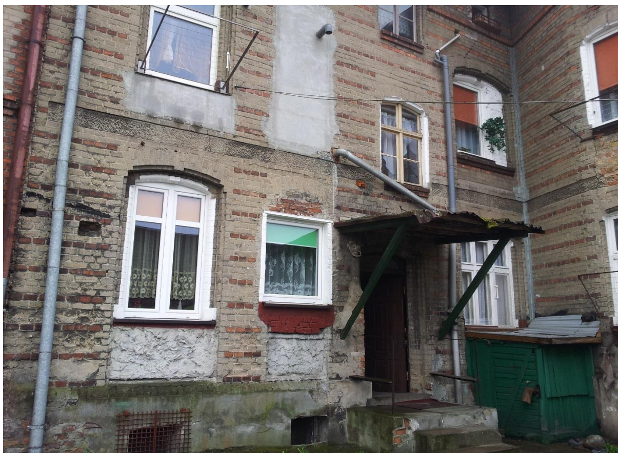
Fot. 5. Elewacja – ul. Mickiewicza
